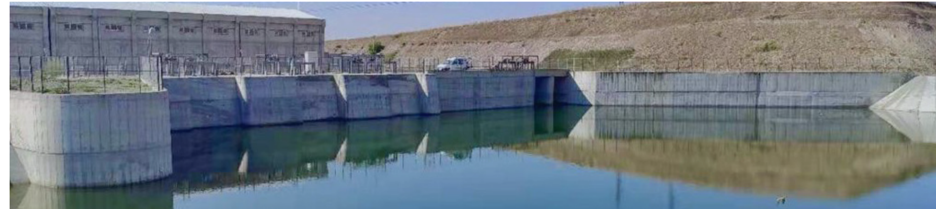
Hidaş Elektrik Üretimi, Hidroelektrik Santral
